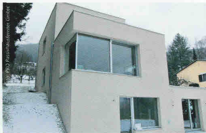
Die SmartWin-Passivhausfenster zeichnen sich u. a. durch ihren schmalen Rahmen aus.
